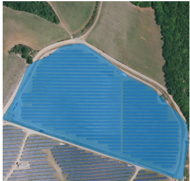
Ou enfin d'un champ photovoltaïque
